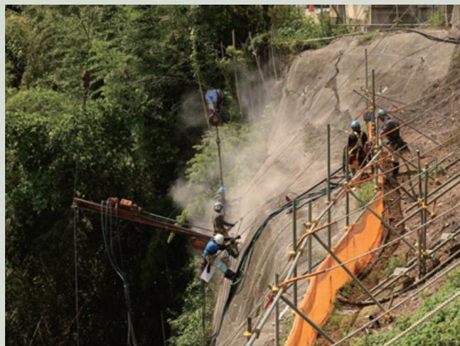
「ロックボルト工削孔作業中」
