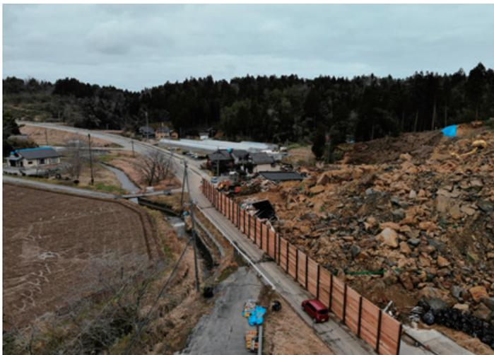
⑪県道の法面崩落への応急対策（写真提供：石川県）
